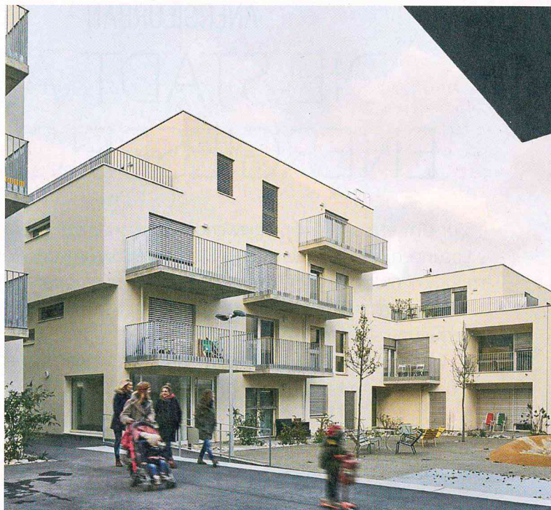
Das MGG22 verspricht unschlagbare Betriebskosten durch Bauteilaktivierung
